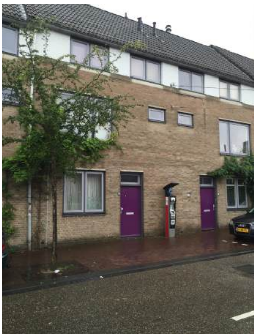
Dit is het huis op de 2de Walstraat 57 zoals het er nu uitziet na de renovatie van begin 21ste eeuw.
